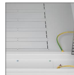
Ввод кабелей осуществляется через лючки в полу и крыше шкафа. Изначально все вводы закрыты выламывающимися заглушками. Возможна установка перфорированных заглушек и щеточных кабельных вводов. Отверстия под вент. блоки также изначально заглушены.
